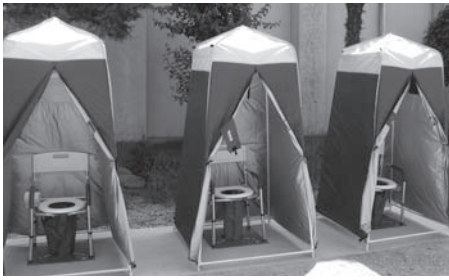
今年度すべての小中学校に整備が完了する災害用マンホールトイレ
