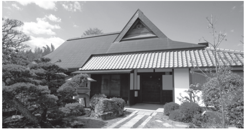
垂直に屋根が交差する入母屋造の主屋(江戸中期築)
