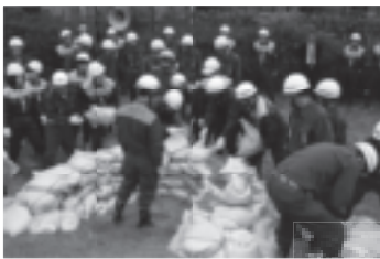
◀土のうを積み上げる様子 ▼杭を打ち込む様子 (いずれも昨年)
