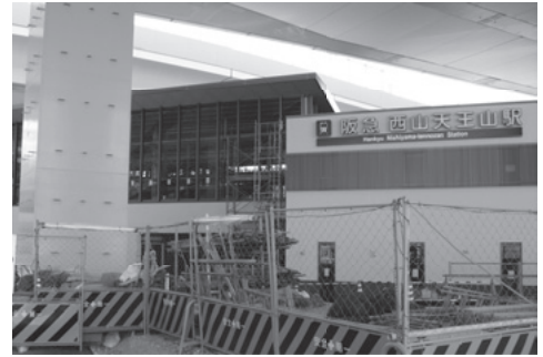
▲建設中の阪急新駅(西山天王山駅)
