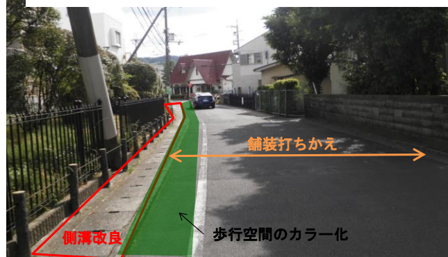
■市道4061号線(2工区)
