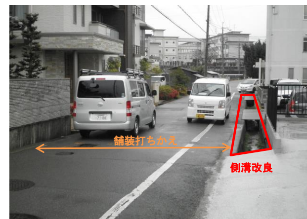
■市道4061号線(1工区)
