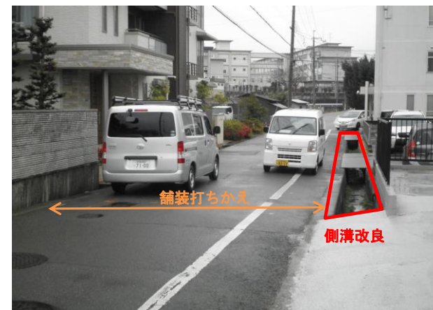
■市道4061号線(1工区)
