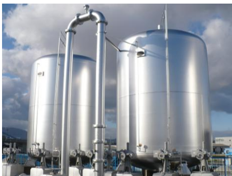
▲ 圧力式急速ろ過機
