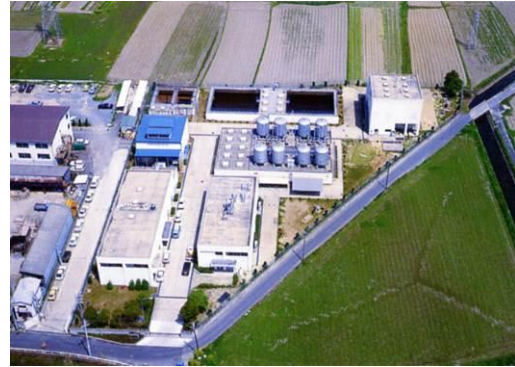
▲ 東第2浄水場 (昭和57年5月稼働)
