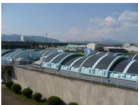
▲ 排水池（太陽光発電パネル）
