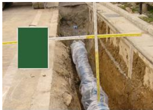
▲ 管路の耐震化事業
