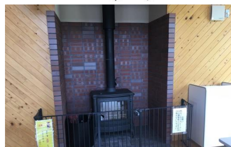
西代里山公園管理棟の薪ストーブ
