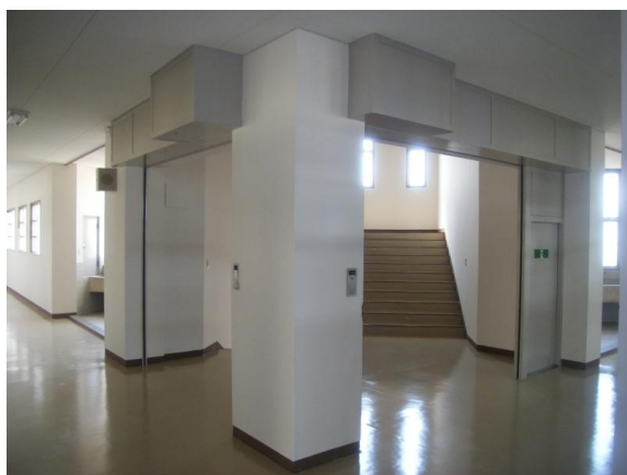
（南西棟 1 階 階段室）
