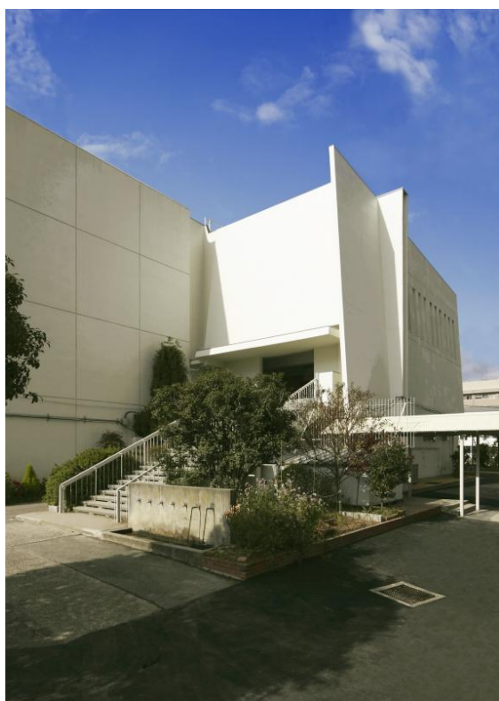
「東棟一昇降口・給食室」
