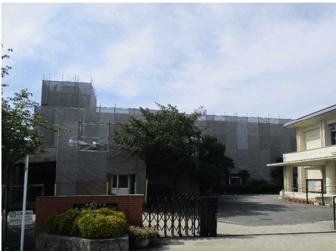
長岡第八小学校（北・南棟）耐震化等工事
