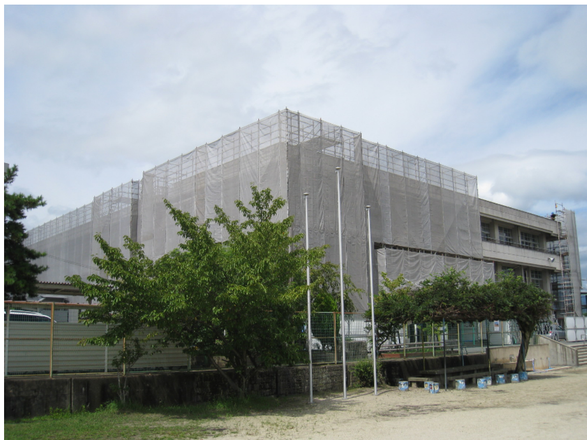
長岡第十小学校（東棟）耐震化等工事
