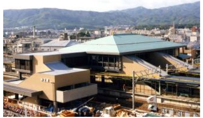
橋上駅となった神足駅（昭和 62 年）
