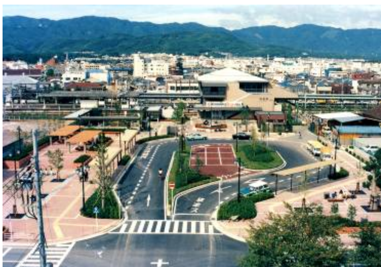
神足駅東口駅前の整備（昭和 63 年）
