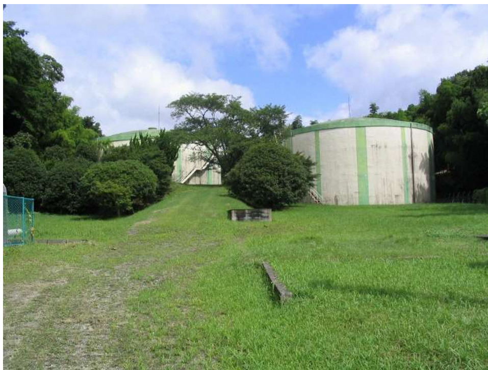
(使用していない長法寺配水池の全景)
