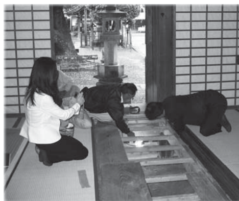
▲楊谷寺阿弥陀堂の基礎部分を調査する様子
