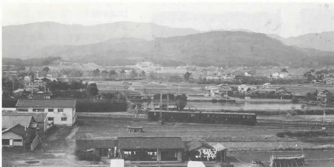
▲昭和36(1961)年ごろ撮影。長岡町役場(今の長岡京市役所)は昭和36年1月、この地に完成しました。役場周辺の農地にはその後、人口の増加に伴って住宅が建ち並ぶようになり、店舗や商業ビルなどの進出も始まりました。
