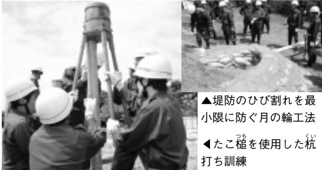
▲堤防のひび割れを最小限に防ぐ月の輪工法
