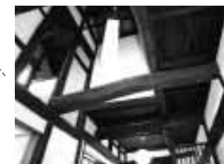
明かり取りの窓がある通り庭の天井
