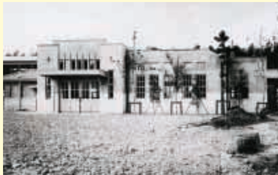
▲新設当時の神足駅駅舎（絵ハガキ）
