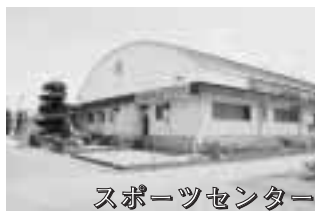
西山公園体育館
