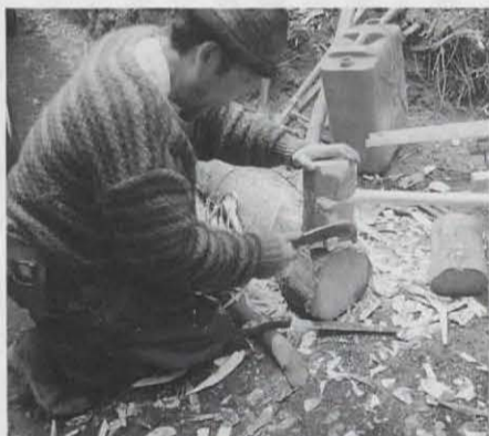
▶「もの作りは、これが原点。炭焼き窯の基礎固めの道具も、その場で作り上げます。みるみるうちに3本の掛矢を完成させました。」
