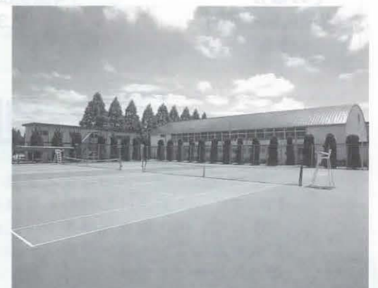
▲夜間照明が設置されるスポーツセンター
