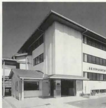
▶長岡京駅東自転車駐車場オープン
