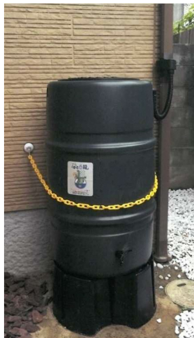
〔雨水貯留タンク 設置例〕
