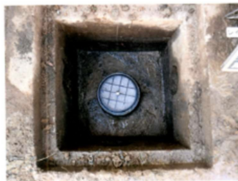
浸透施設（長岡第四中学校地内）
