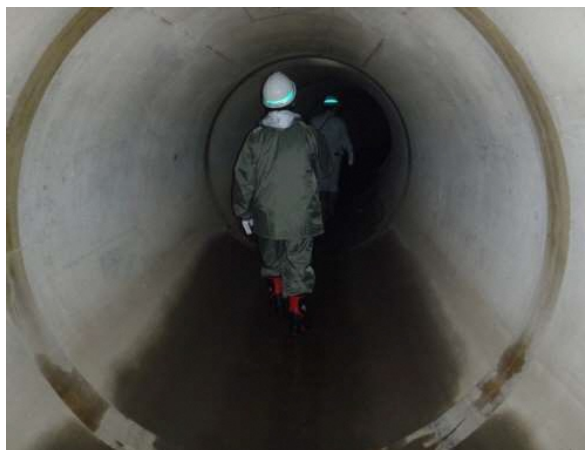
[今里雨水貯留幹線内部 年次点検作業状況]
