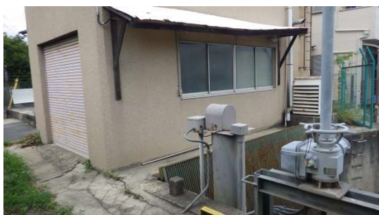
〔神足ポンプ場 外景〕
