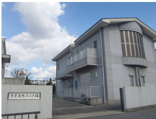
[今里雨水ポンプ場 外景]
