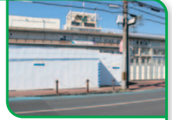
■新庁舎建設予定地
