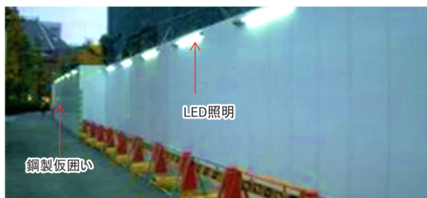
仮囲い夜間照明例
