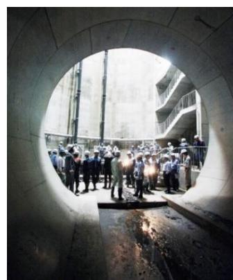
京都府と長岡市、向日市、京都市と共同で整備を進める「いいろは呑龍トンネル」は、雨水が流入して増水した雨水排水路から水をトンネル内に取り込み、一時的に貯留し、河川や水路へ放流することにより、浸水被害を防ごうというものです。令和5年度の完成を目指しており、これも気候変動への適応策の一つです。
