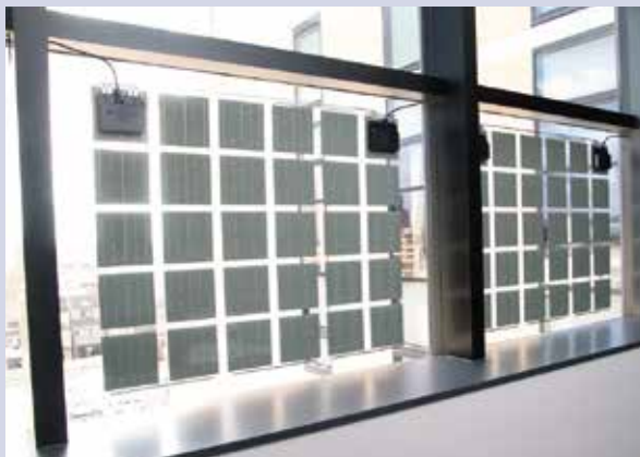
太陽光発電パネルが設置された窓ガラス
