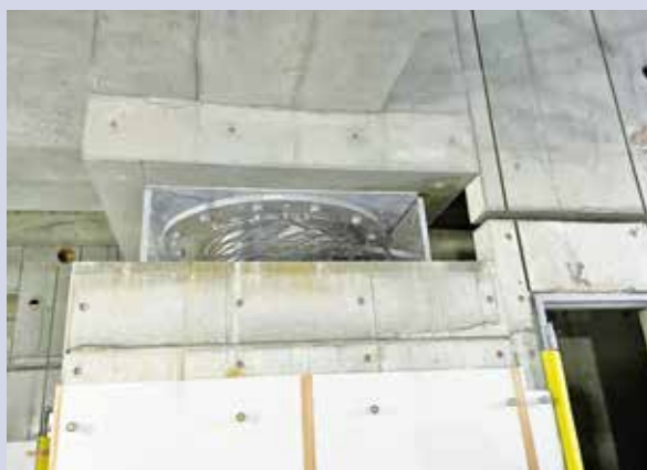
地震の揺れを軽減する免震構造
