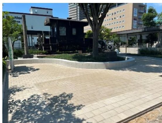
施工した雨水貯留浸透型ブロック
