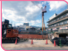
■新庁舎の建設風景
