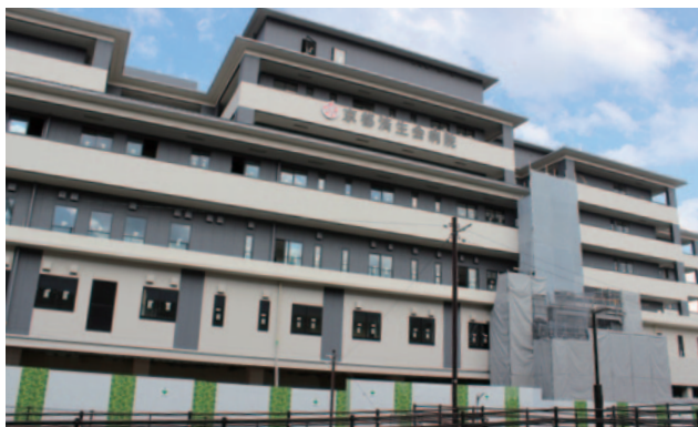
▲移転工事の進む済生会京都府病院（新名称：京都済生会病院）
