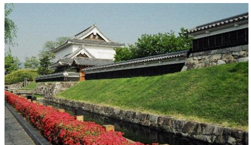
勝竜寺城公園の模擬天守風管理棟
