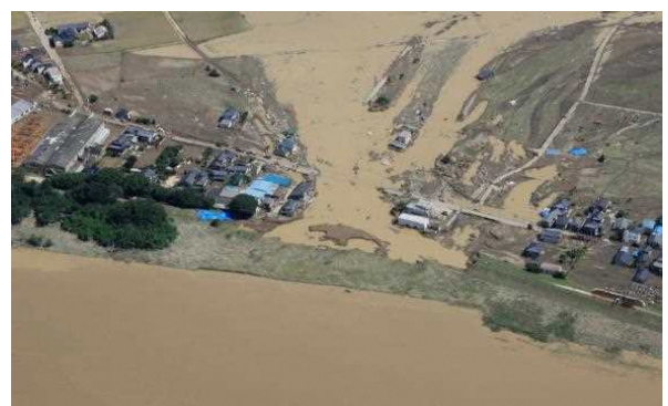
堤防決壊による家屋の流失(鬼怒川)
