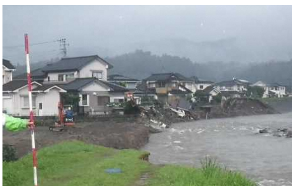
河岸侵食による家屋の倒壊(花月川)
