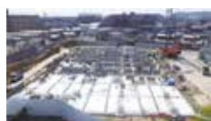
工事の様子(3月)
