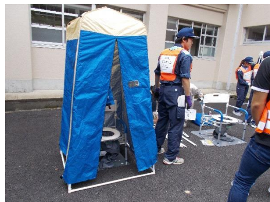
マンホールトイレの組み立て
