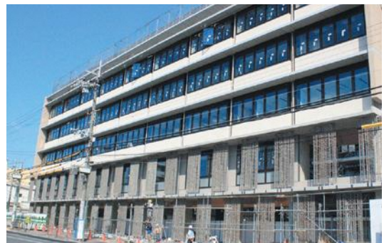
▲工事が進む市役所1期庁舎
