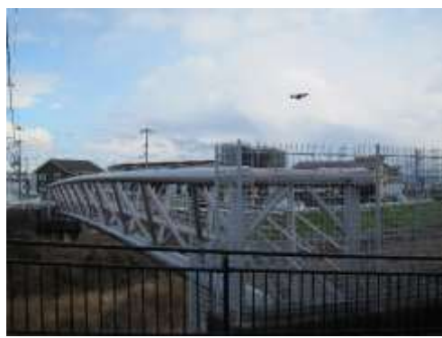
小畑川に架設の水管橋を点検 令和4年度実施
