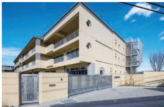
▲令和4年度から整備を進めている長岡第四小学校
