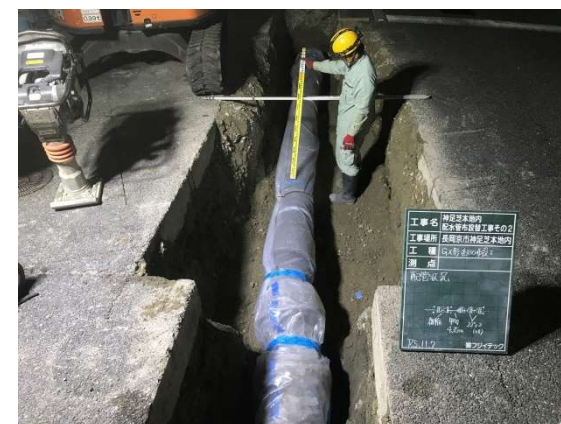
基幹管路耐震化整備工事
