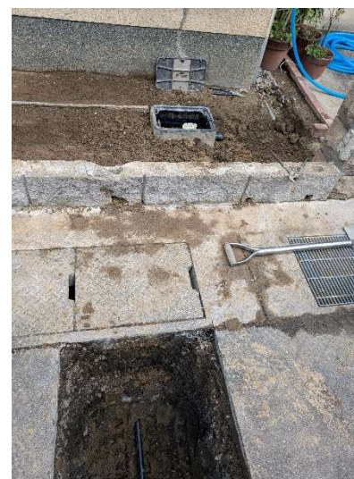
鉛製給水管解消工事 (メーター周辺の残存解消状況)
