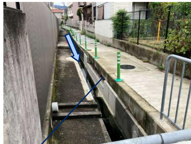
水位が上がると施設内に雨水が分水される
