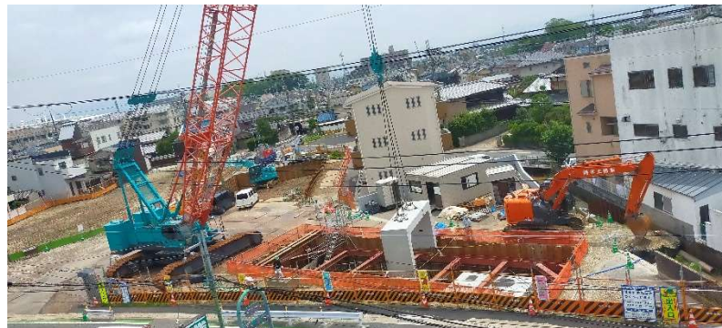
貯留施設設置時
