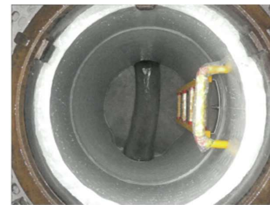
完了後 人孔更生 ライニング工法
