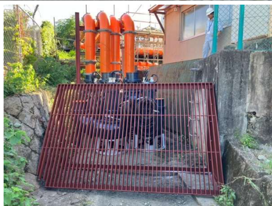
工事期間中の仮排水ポンプ設置状況（令和6年9月時点）
