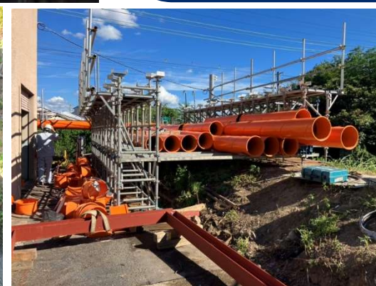
工事期間中の仮排水ポンプ設置状況（令和6年9月時点）
