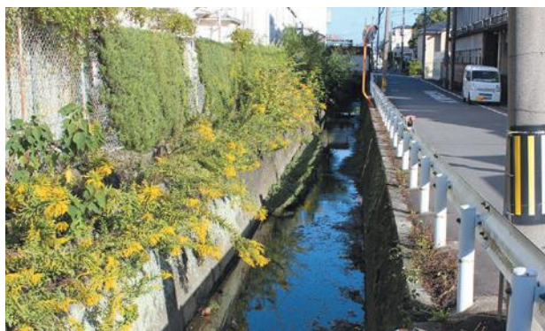
▲ あんきょ 暗渠化が計画されている旧庁舎北側道路
