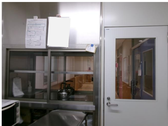
⑰保育室廊下出入口・カウンター
