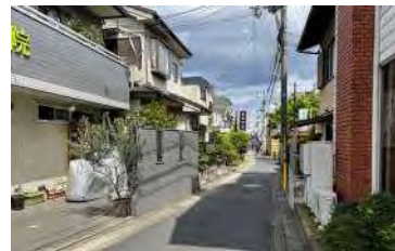
消防車や救急車が入れない狭隘道路
