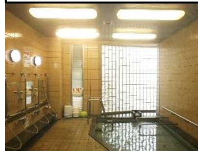
⑦給排水設備改修
