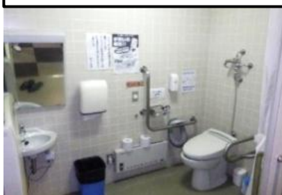
③トイレ改修
