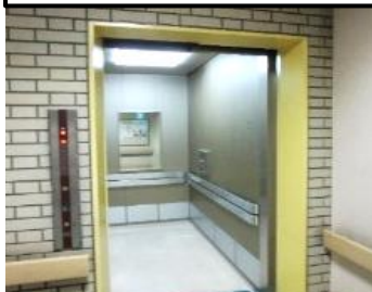
⑨エレベーター更新
