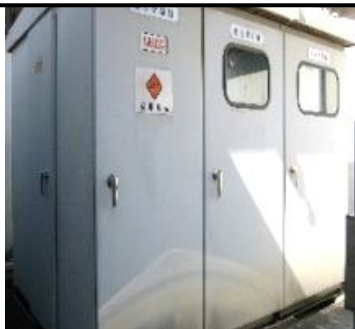
⑤電気設備改修
