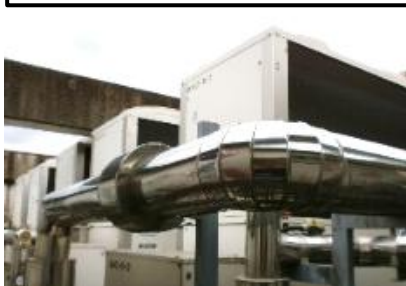
⑥空調設備改修
