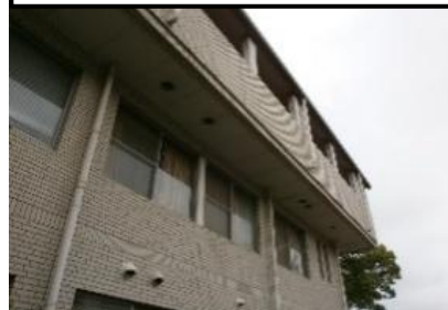
①外壁・防水改修
