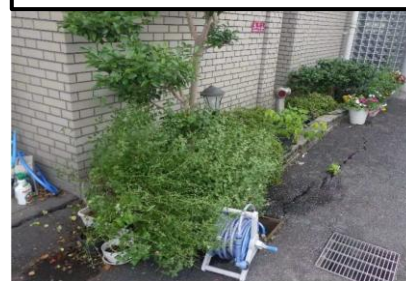
④外構改修
