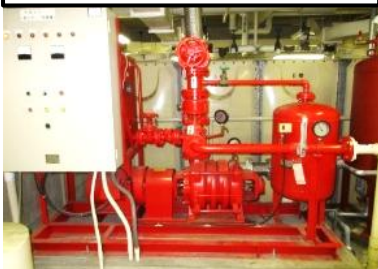
⑧消防設備更新
